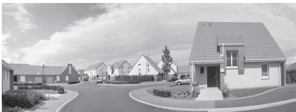
Maison individuelle 55 m 2 , proche banlieue vide, cuisine équipée Loyer : voir avec l'agence
